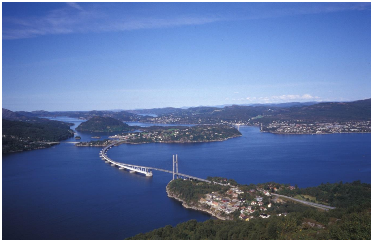
Figur 3. Nordhordlandsbron över Salhusfjorden.
